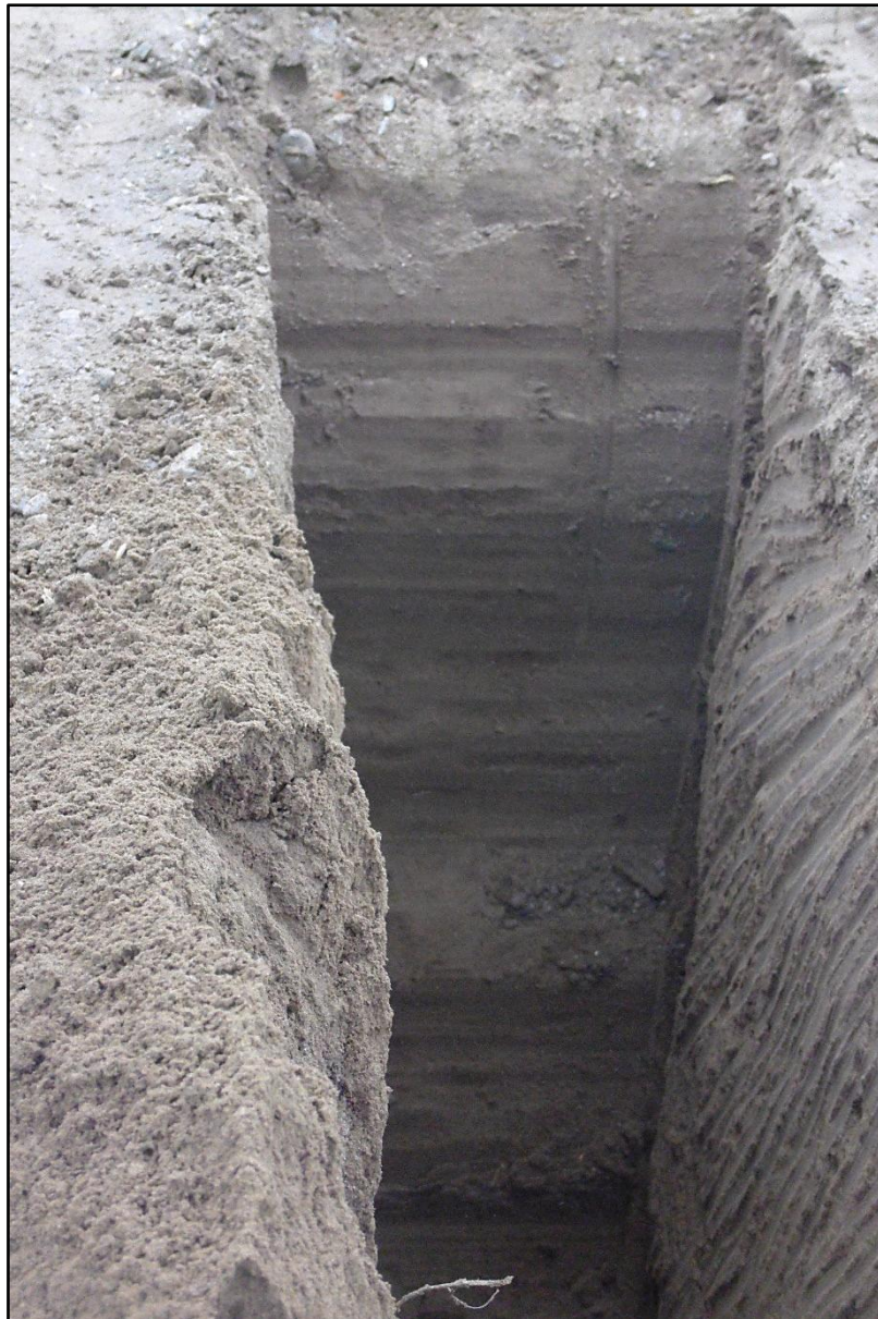
Figura 11: Detalle del perfil del suelo al interior de la zanja
