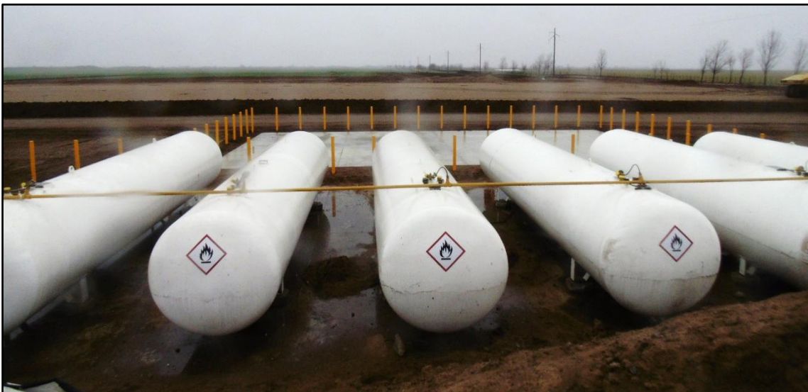
Figura 23: Detalle de los zeppelín de GLP
