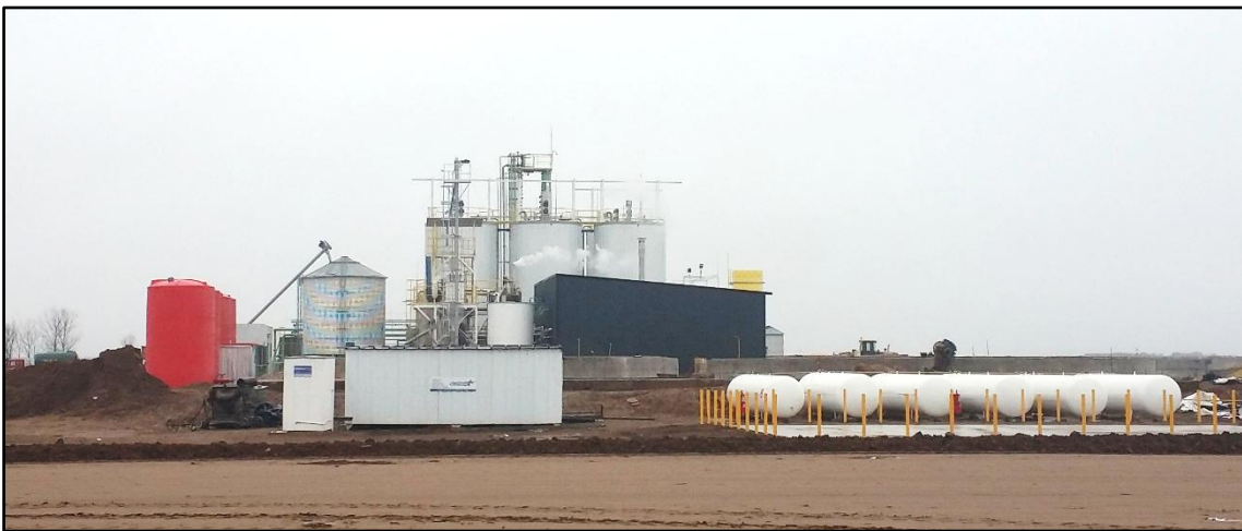
Figura 23: Detalle de los zeppelín de GLP
