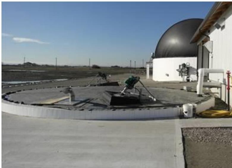
**Tanque de Recepción de Líquidos. Se observa el acople tipo camlock. Debajo de la conexión se accede al filtro de barras.**
