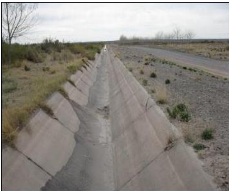
Figura 18. Canal de hormigón a cielo abierto.
