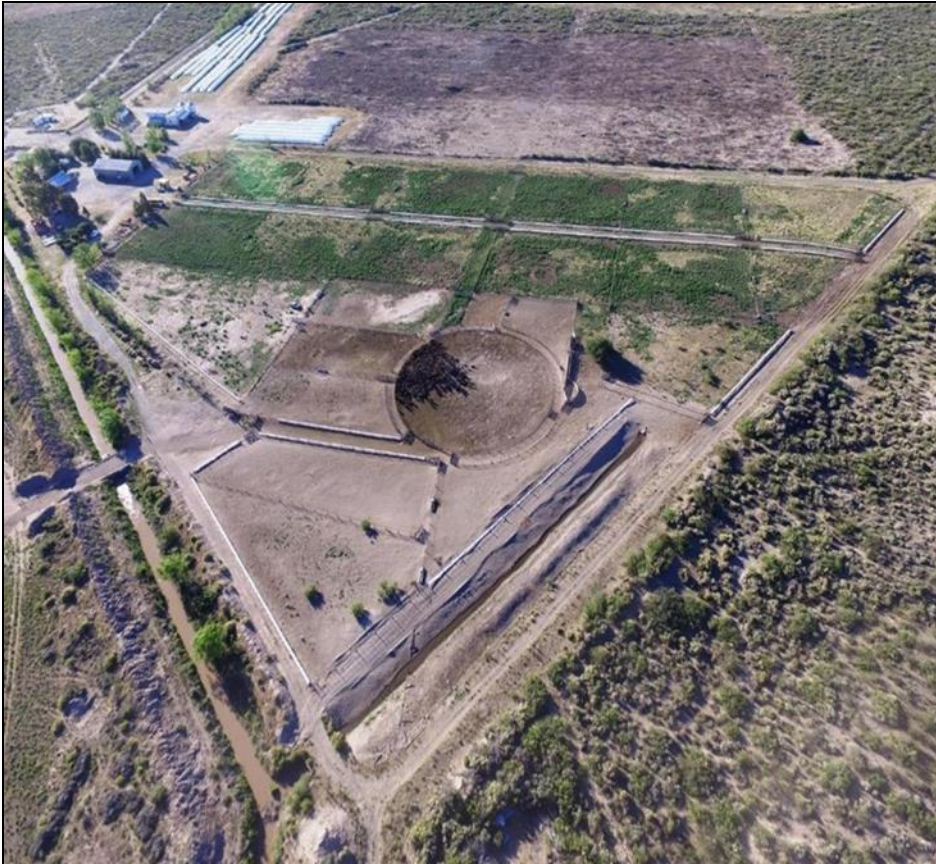
Foto 17: Vista en perspectiva de corrales preexistentes.
