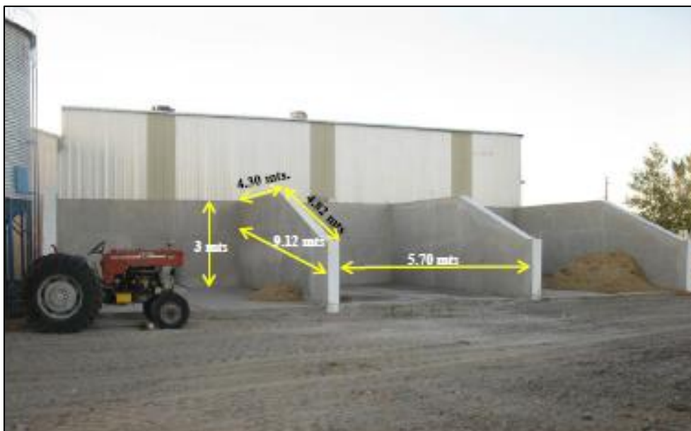
Figura 48: foto y medidas de las celdas de alimentación
