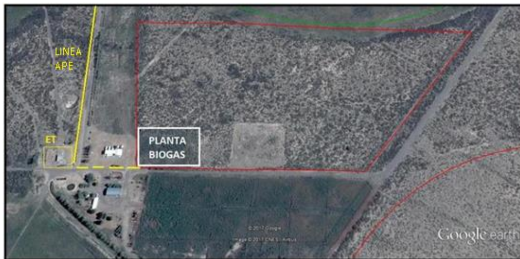
Figura 4. Sector de emplazamiento de la planta de Generación, Estación Transformadora y línea eléctrica de la Administración Provincial de Energía (APE).
