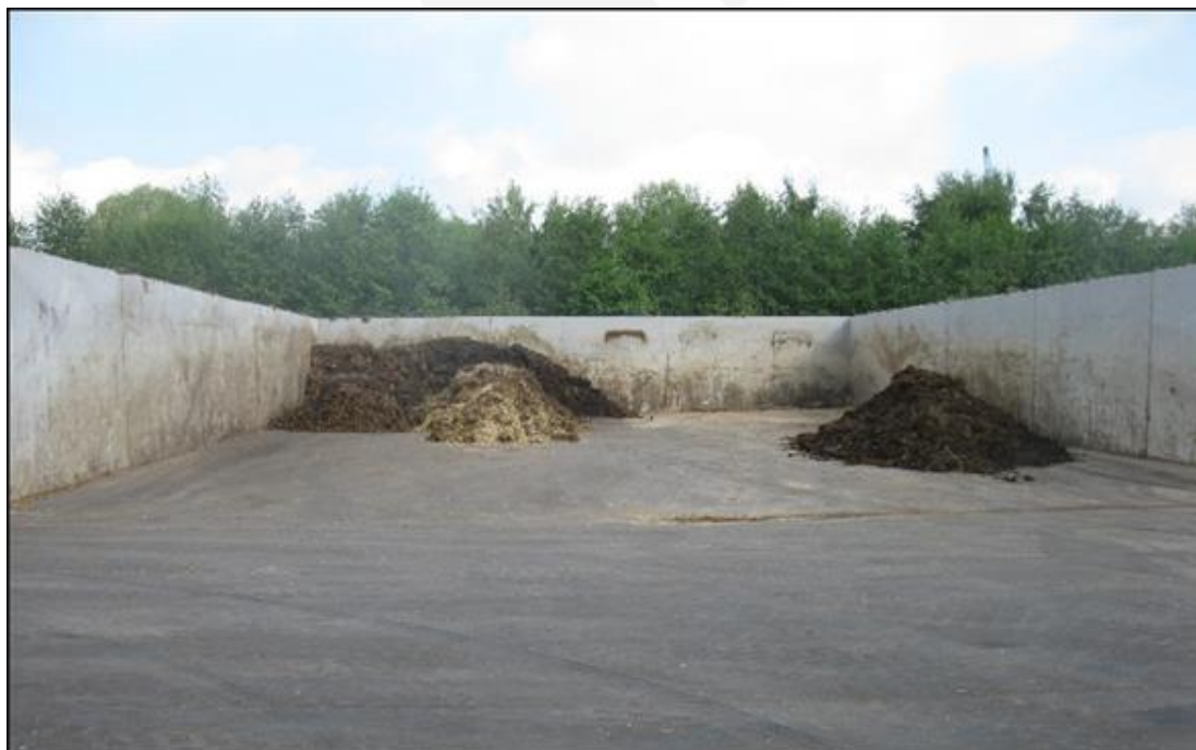
Figura 50: la fotografía muestra una playa similar a la que se construirá para el digestato sólido. Los taludes laterales tendrán 4 m de altura.
