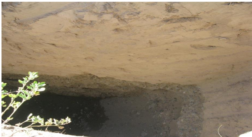
Figura 19: Perfil del suelo perforación del pivot 6.
