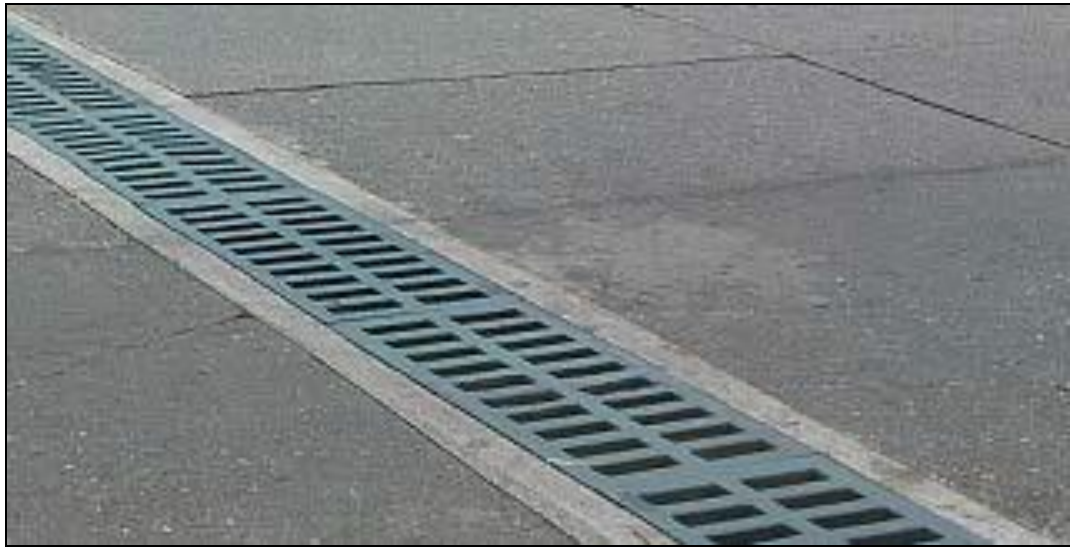
Figura 53: Rejillas de protección de la red de drenaje
